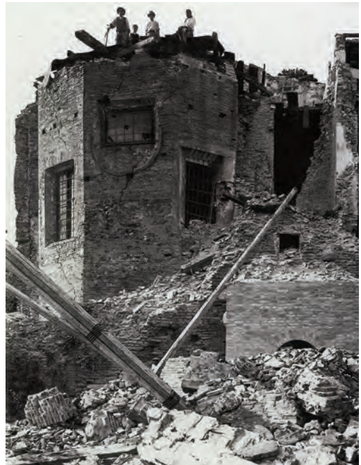
Fig. 13. Rimini, terremoto del 1916. Crolli e demolizioni dell'abside della chiesa di San Bartolomeo (Istituto Centrale per il Catalogo e la Documentazione. Fototeca Nazionale, Foto serie E, n.4026).
