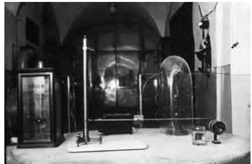
Fig. 5. Pilastro sismico del Gabinetto sismologico sotterraneo Alfani, in una lastra fotografica del 1910 circa. In primo piano un inclinografo realizzato da Alfani per misurare l'influenza sulle registrazioni sismiche delle variazioni di temperatura durante la giornata.
